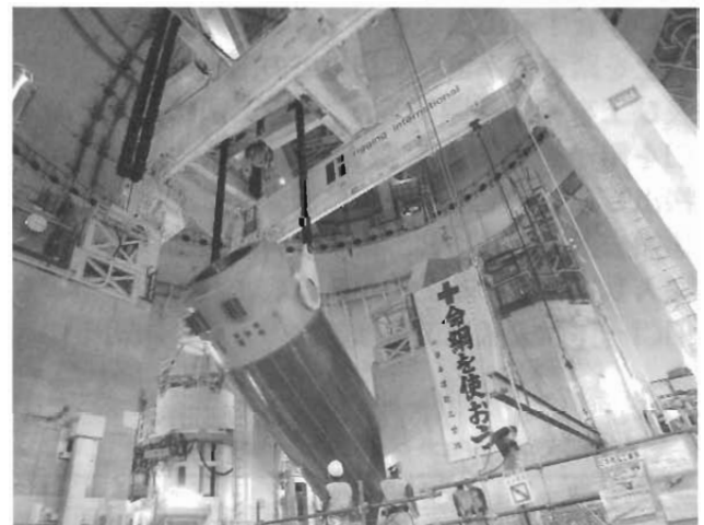
(2) CV内特設クレーンと保管容器
