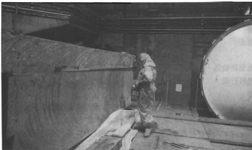
ダイヤモンドソーにより切断された原子炉圧力容器シールドプラグ
